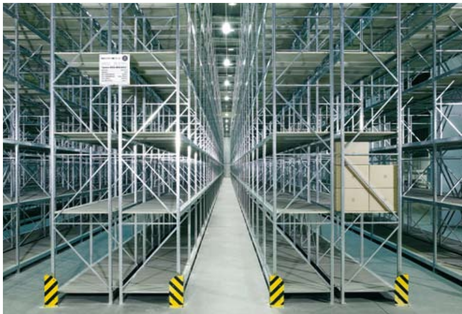
MINI-RACK® frames in verzinkte uitvoering tot 12 meter hoogte beschikbaar: in dit project 9 meter.
