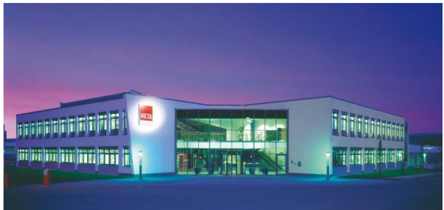
Siège de META Regalbau GmbH & Co. KG à Arnsberg
