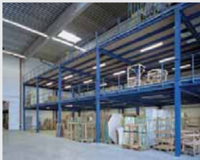
Palettenregalanlage mit Stahlbaubühne überbaut
