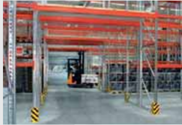
Durchfahrten für den Warentransport
